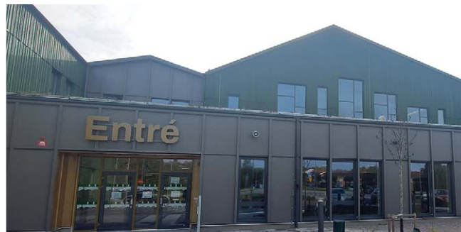
Holmängensskolan valde WOOD-X, både till fasad och till interiör inklädnad.
